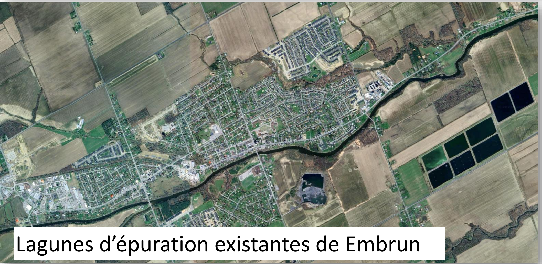
Lagunes d'épuration existantes de Russell
